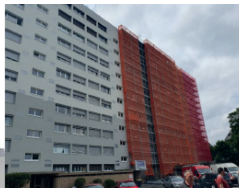
Avancée des travaux au 04.05.2024
